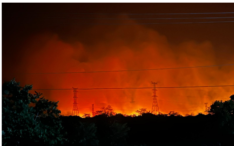
Gráfico No. 5 Incendio bajo las Líneas de Transmisión de 400 kV Tabasco Potencia LT-A3Q00 y LT-A3Q10 Escárcega.
